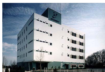
営電本社ビル (神奈川県川崎市麻生区2-7-1)
